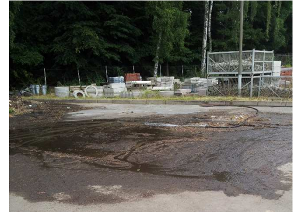
Bildquelle: Waschplatz © SE Kanalbau Langenhagen
