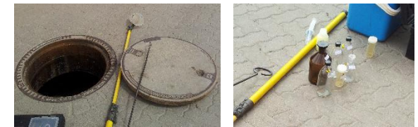
Bildquelle: Waschplatz © SE Kanalbau Langenhagen
